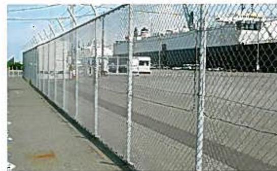
フェンスとゲート（東扇島外貿埠頭）
