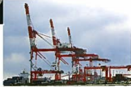
ガントリークレーン Gantry Crane
