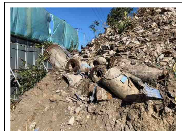
写真④ 堆積物の状況
