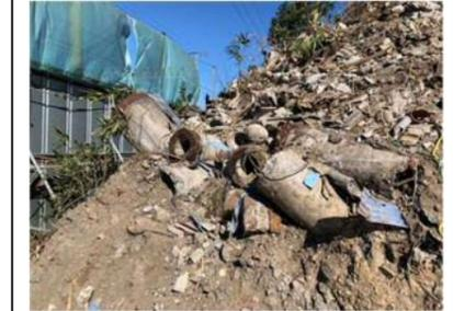
堆積物中には、土砂だけでなく多くのコンクリートガラや塩ビ管等の廃棄物が散在し、堆積物全体の処分重量を想定することは困難な状況
