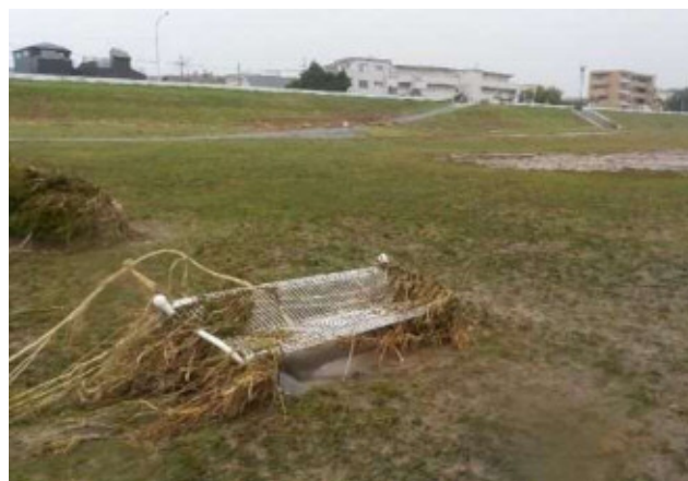
● 菅多目的広場 土砂堆積・施設損傷
