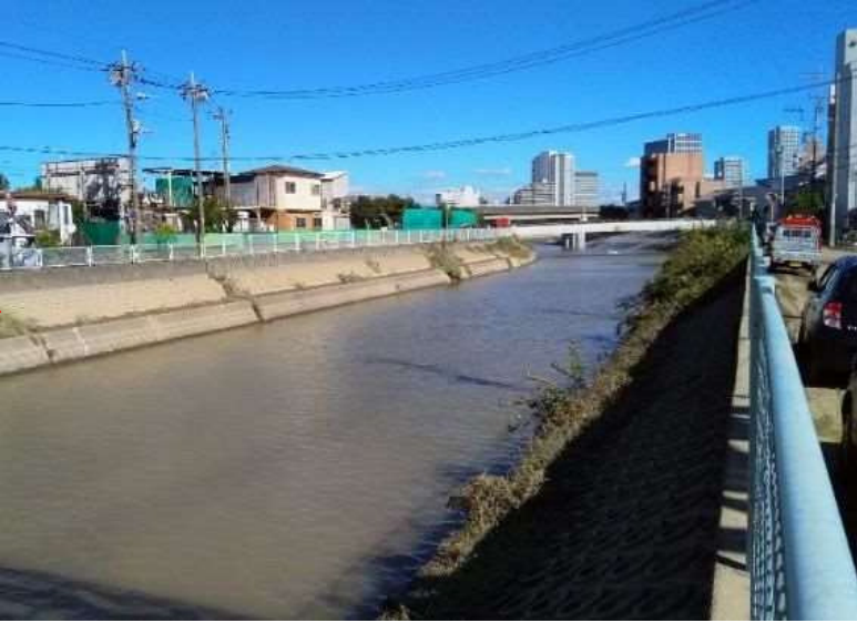
平瀬川上流側から多摩川との合流部を望む
