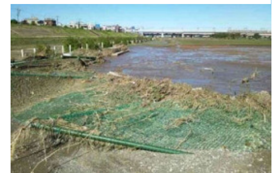
● 諏訪球場 土砂堆積、バックネット損傷
