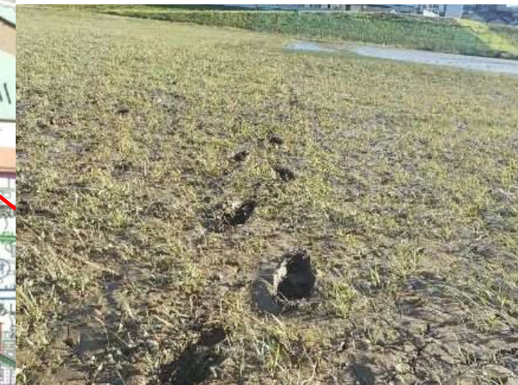
● 殿町河川敷自由広場 土砂堆積
