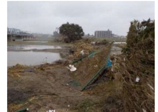
● 上丸子山王町少年野球場 バックネット破損
