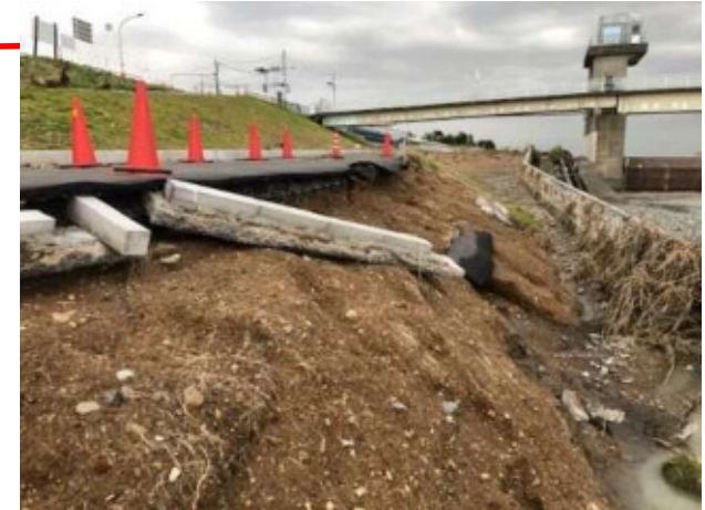
● ピクニック橋 坂路法尻流出、舗装ブロック一部流出、流木堆積
