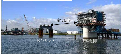
架設前（B4ベントーP4橋脚）全景
