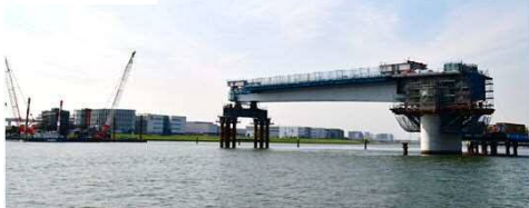
橋桁架設完了
