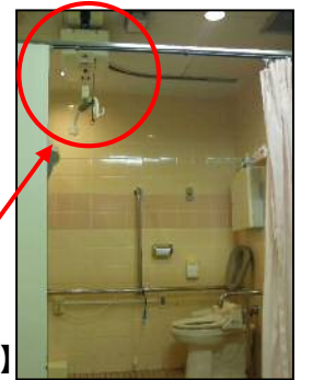
天井吊り下げ式 介護リフト
