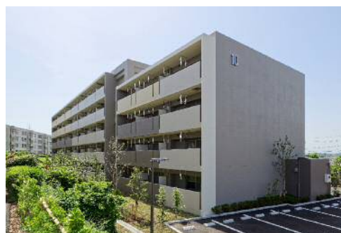
（建替えを行った市営住宅）
