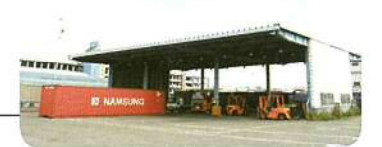
全天候型検査場 All-weather inspection Areas
