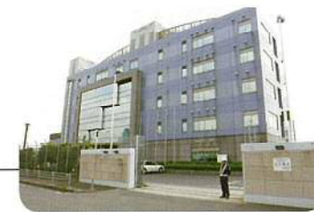
ターミナル入口 管理棟 Terminal entrance and office building
