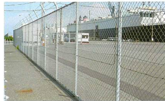
フェンスとゲート（東扇島外貿埠頭）
