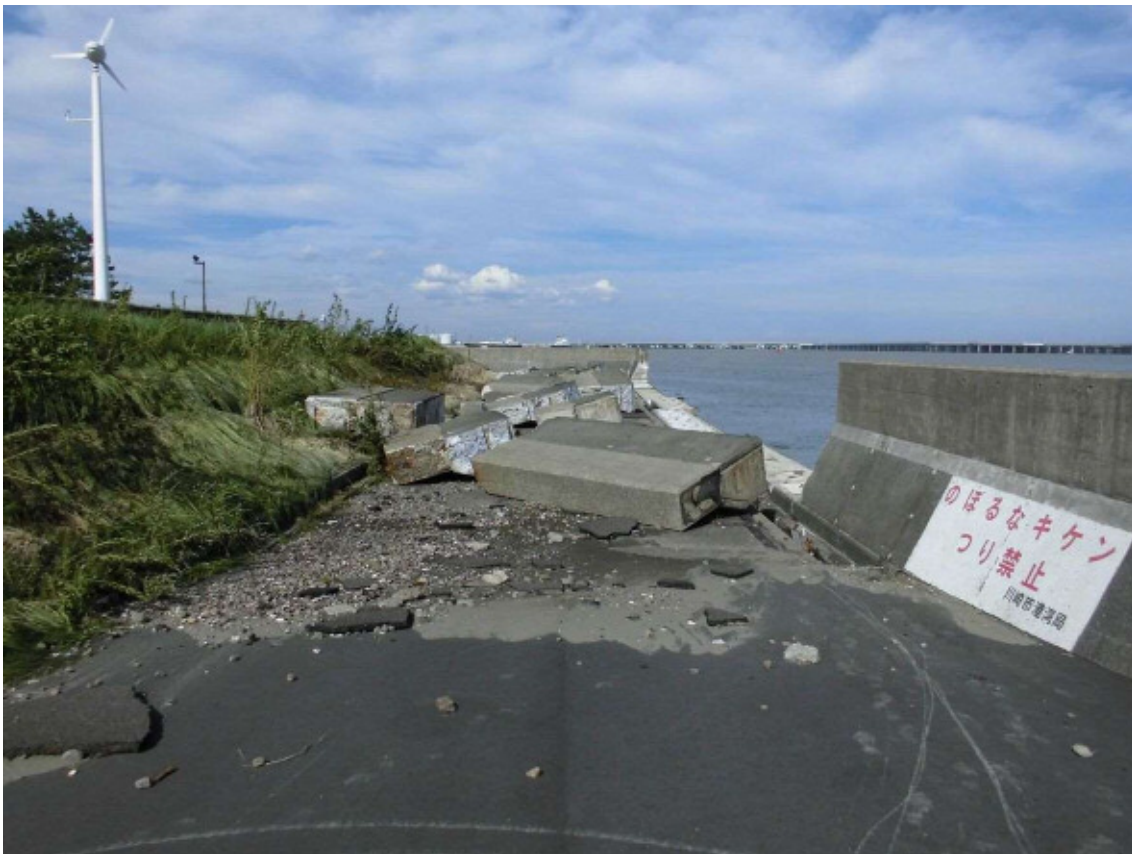
現況写真（浮島つり園） 表面舗装の大規模な剥離
