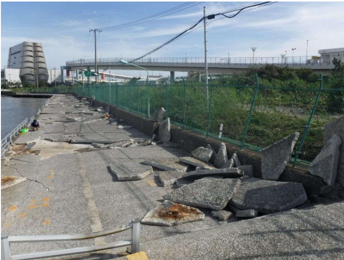
現況写真（浮島つり園） 表面舗装の大規模な剥離
