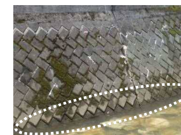
護岸の変状(ブロック隙間の拡大)
