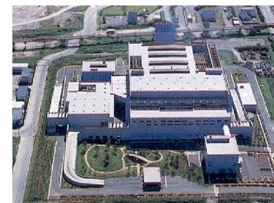
《完成時（H7年）の浮島処理センター》
