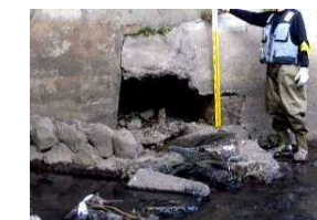
護岸背面部の空洞
