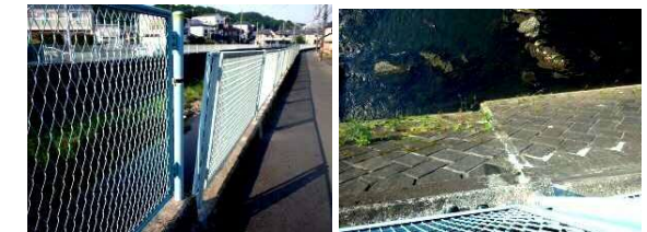
変状による護岸施設の目違い
