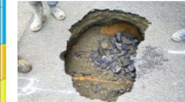
下水管きよの老朽化に起因する道路陥没
