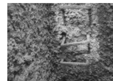
硫化水素による槽内部の劣化
