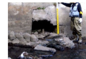
護岸背面部の空洞
