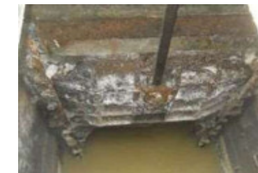
硫化水素による槽内部の劣化
