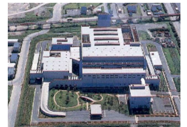
《現在の浮島処理センター》
