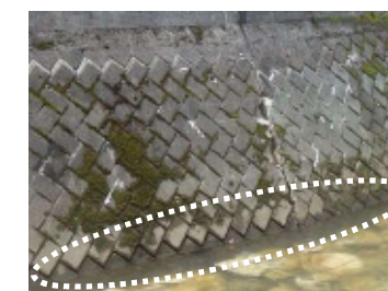
護岸の変状(ブロック隙間の拡大)
