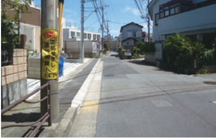
狹隘区間の手前に設置した電柱幕
