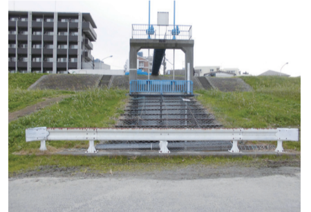
山王排水樋管(中原区)
