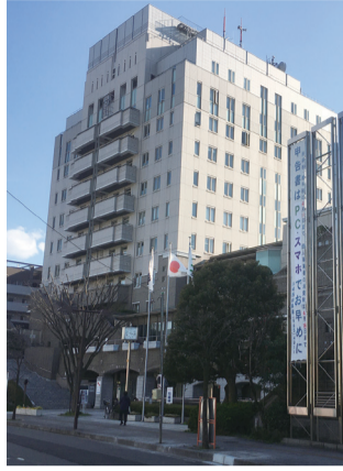
多摩防災センター（多摩区総合庁舎6階）
