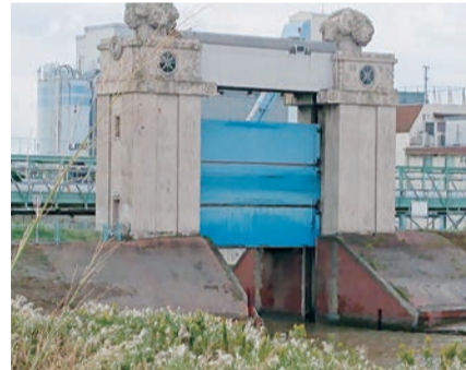
川崎河港水門(川崎区)
