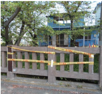
立ち入り禁止のテープが貼られた転落防止柵
