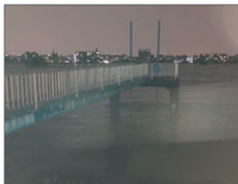
排水樋管周辺状況(当日)
