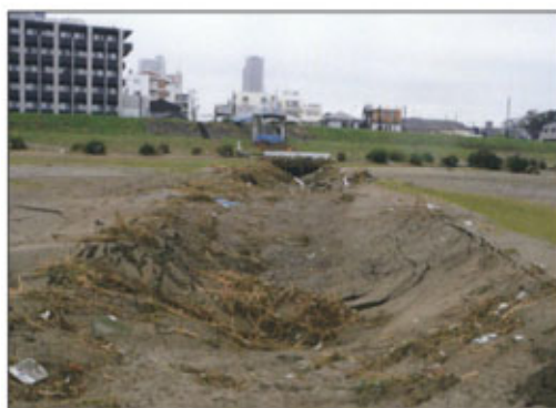
排水樋管周辺状況(台風後)
