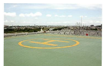
●屋上ヘリポート
