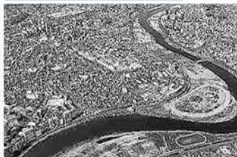
国道 1 号多摩川大橋周辺
