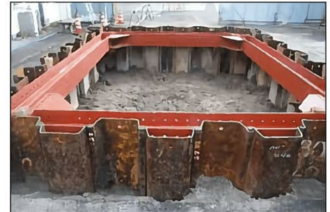
剛性のある土留め壁の設置
