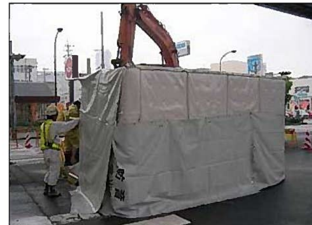
仮囲い・防音シート等の設置(※)
