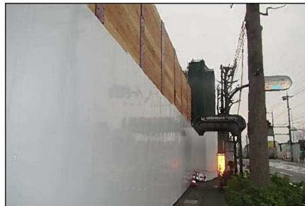
防護設備の設置
