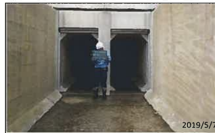
樋管ゲート写真
