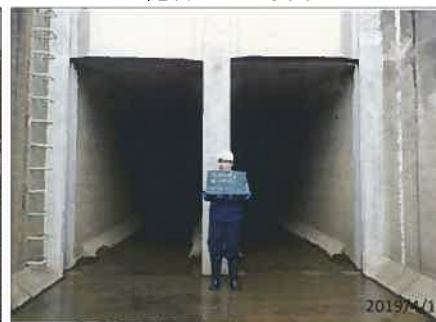
樋管ゲート写真
