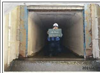
樋管ゲート写真
