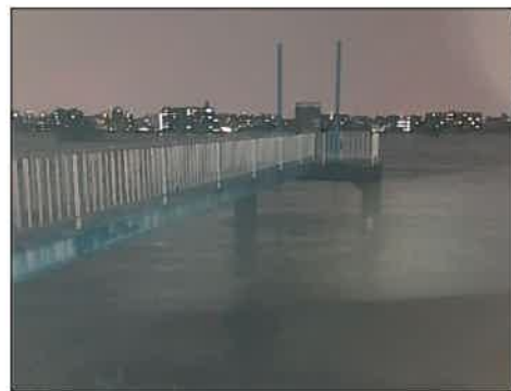
排水樋管周辺状況(当日)
