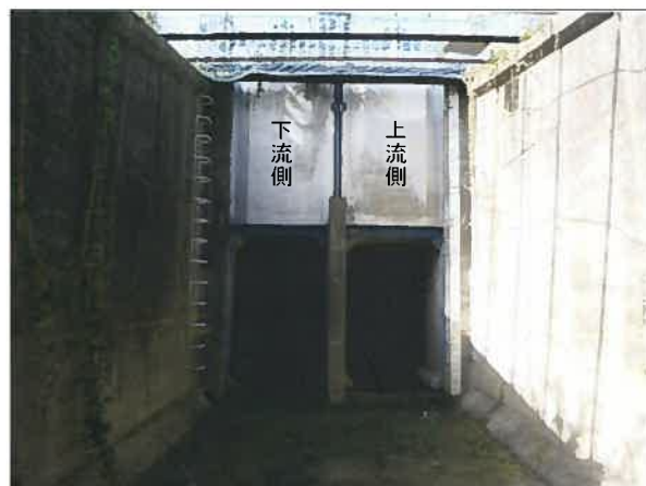
10月10日点検状況
