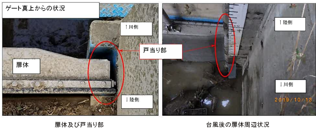
写真 9-2-3 山王排水樋管ゲートの戸当り部の状況
