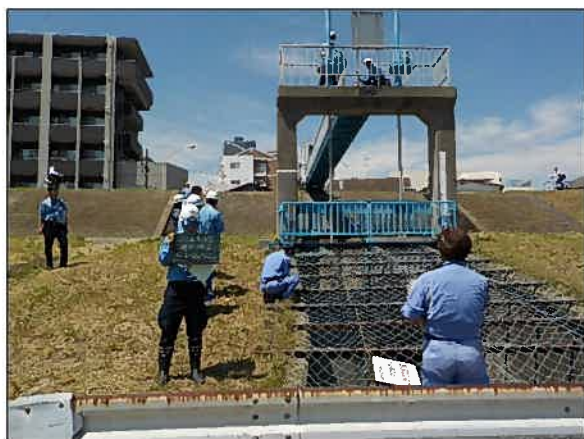
河川管理者による検査状況
