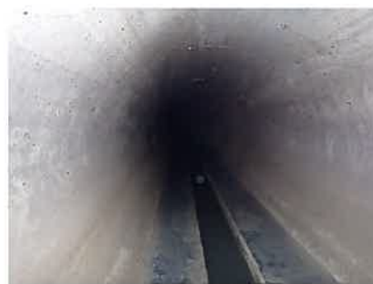
最下流部マンホールから上流
