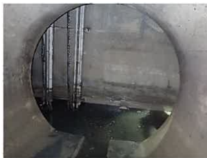
最下流部マンホール
