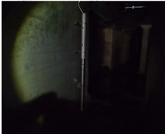
内水位計（管きよ内水位）
