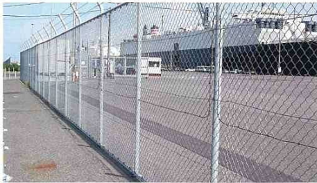
フェンスとゲート (東扇島外貨埠頭)
