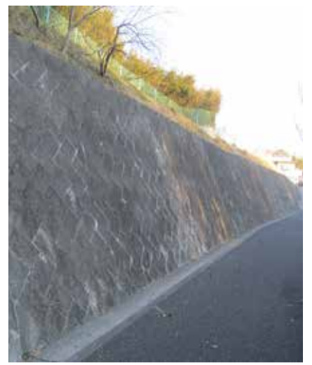
道路沿いの斜面の一例(点検済)
