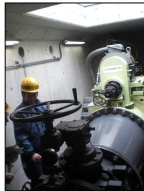
鷺沼水力発電所のマイクロ水力発電機。鷺沼配水池に設置され、上水の水流を利用している。
