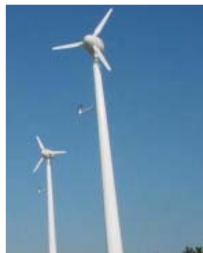
川崎区浮島公園「海風の森」の風車 3kWのものが3基。2005年1月設置。
