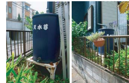
岡上Nさんの天水尊(墨田区が推奨しているもの)容量200ℓ
