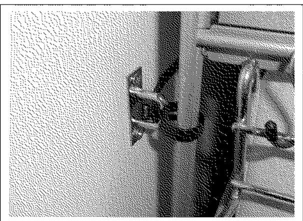
壁に取り付けたアイプレートと金属棚を結束バンドで繋ぐ
