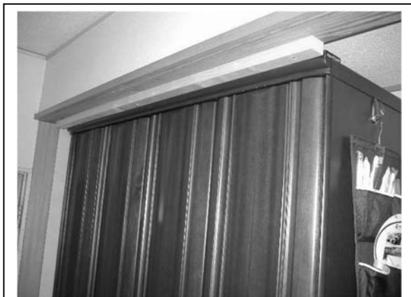
鴨居に板を足し、家具が前に転倒しないよう固定
