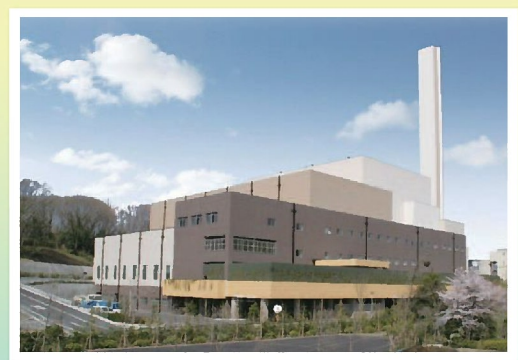
リサイクルパークあさお王禅寺処理センター
