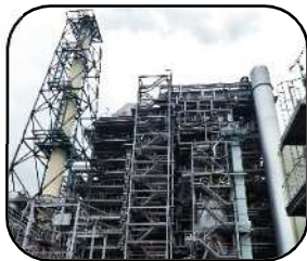
川崎バイオマス発電所
