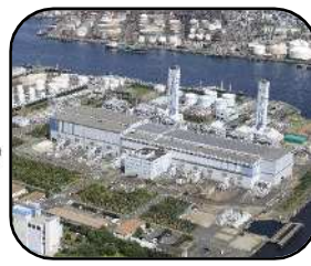
JERA 川崎火力発電所
