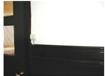
基本的には、配管は隠せないもので、見せながら新しい設備を導入していくことが一般的に行われます。配管が見えるとみっともない思いがちで、次にどうするかという、同じ昭和電工の例で天井を張ると配管が見えなくなるので、隠してしまおうと天井を低くします。天井が高いと冷暖房の効率も悪く、天井を低くすると暖房効率も上がるし、天井板で隠してしまえば配管が見えなくなる、このようなケースがよくあります。しかし、そもそも非常に天井の高いところが昔の建物、歴史的な建物の良さでもあり、無理にこれを隠そうとするといいことはありません。
