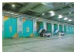
ピット投入口
