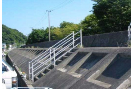
海岸や川沿いにある堤防・防潮堤
