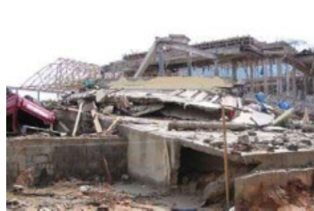
津波による建物破壊
