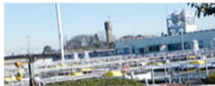
西長沢浄水場
