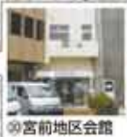
⑨ 宮前地区会館
