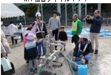
応急給水拠点設置
