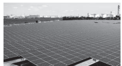
【扇島太陽光発電所（最大出力 13,000kW）】 ※見学不可
