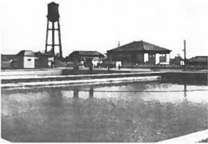
戸手浄水場 (大正13年頃) 【出典】『川崎市水道八十年史』
