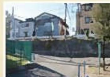
かつて有吉堤があった中原区上平岡付近
