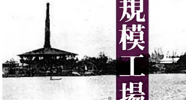
御幸煉瓦製造所 【出典】『橋本邸案内』
