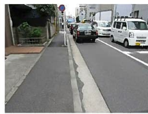
南河原交差点から南部市場前 交差点までの歩道 (段差等)
