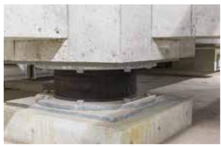
▲地震がきても建物が倒壊しないように区役所として初めて免震構造を採用
