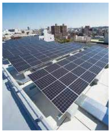
▲太陽光発電設備を屋上に設置し、蓄電池と合わせて災害時に利用可能
