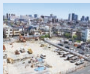
5月現在の様子 (区役所側から撮影)
