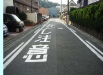
注意喚起路面標示の新設
