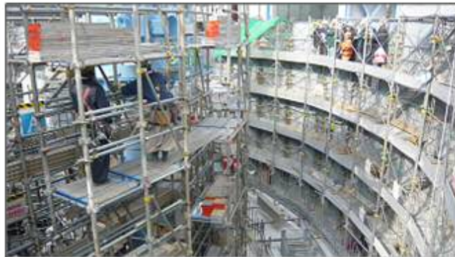
矢上川地下調節池
