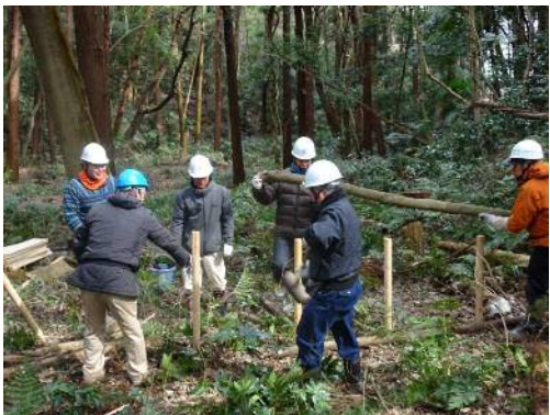
カントリーヘッジの設置
