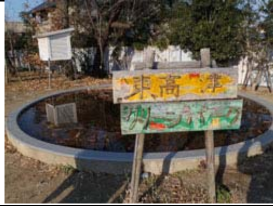
劣化した看板
