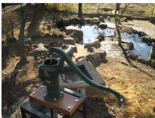
完成したビオトープ
