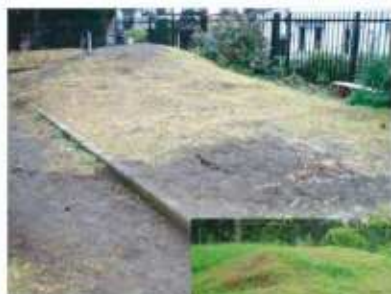
施工前の様子
