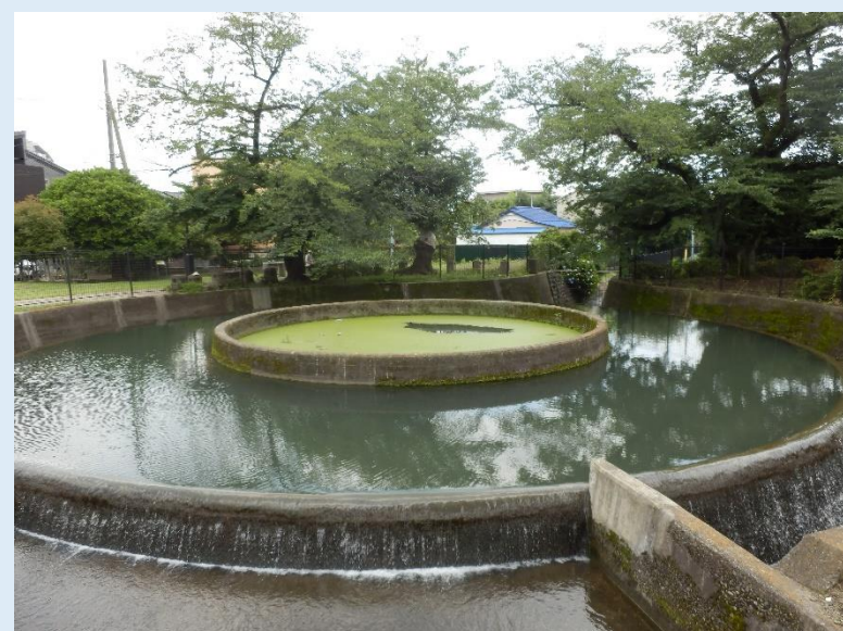
久地円筒分水
