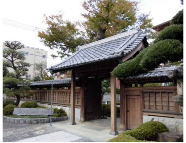
旧原家住宅表門 正面東から
