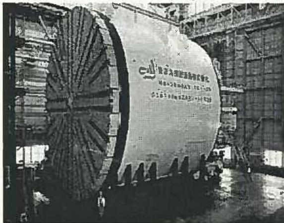
シールドマシンは、円筒状で、先端に取り付けられた刃が回転しながら、高圧の泥水を使用し、崩れないように押さえられた土を削りとる。泥水となった土はポンプで排出し、マシン後方では1.5m進むごとにセグメントをリング状に組立て、トンネル壁を構築していくのである。この掘削、泥水の給排水、セグメント組立はすべて自動化されている。
